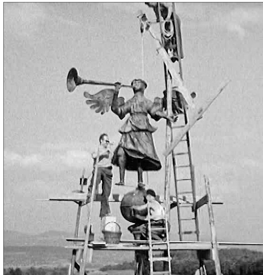
Szene von den Renovationsarbeiten an der Klosterkirche im Jahr 1954 Bilder: zVg
